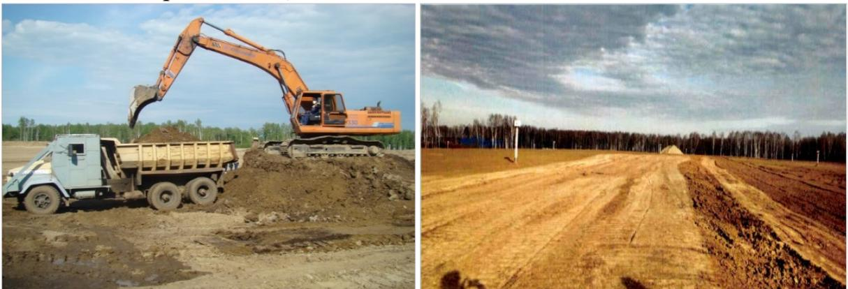
Рисунок В.4.3 - Засыпка водоема-хранилища Б-1 (АО «СХК»)
